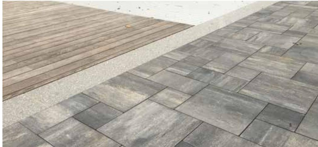
**Baradel Paysage réalise tout type de plages de piscines (pierres naturelles, céramiques, bois, béton...). Ci-dessus, des pavés multi-formats en béton gris accompagnent une terrasse réalisée en thermotrène et donnent un côté contemporain à l'aménagement. Les margelles en granit gris, avec finition grenailée, se prolongent dans la plage de piscine et séparent les deux revêtements.**
